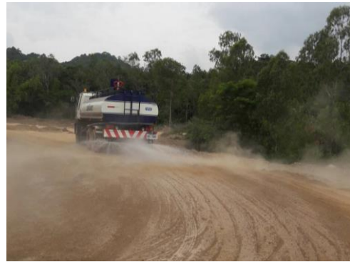
รูปที่ 5 การฉีดพรมน้ำบริเวณเส้นทางขนส่งแร่และบริเวณหน้าเหมือง
